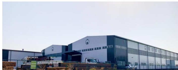
本社倉庫・加工工場（群馬県玉村町）
