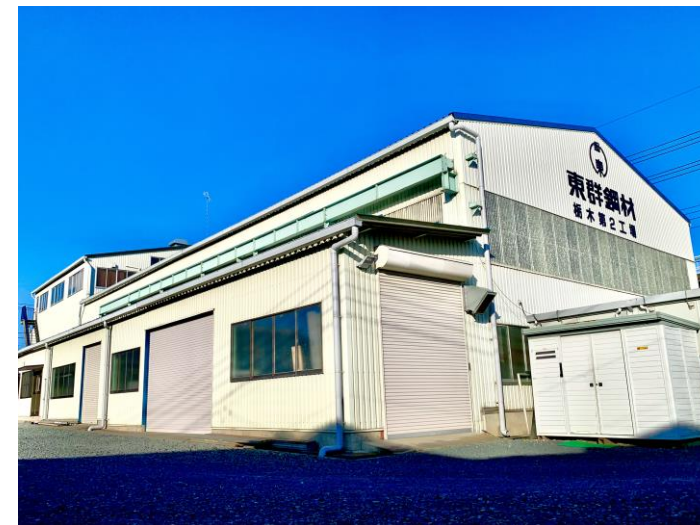
栃木第二工場（栃木県栃木市）
